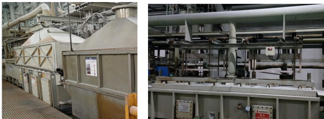
图 6.1-2 同类型企业酸碱雾收集方式现场照
